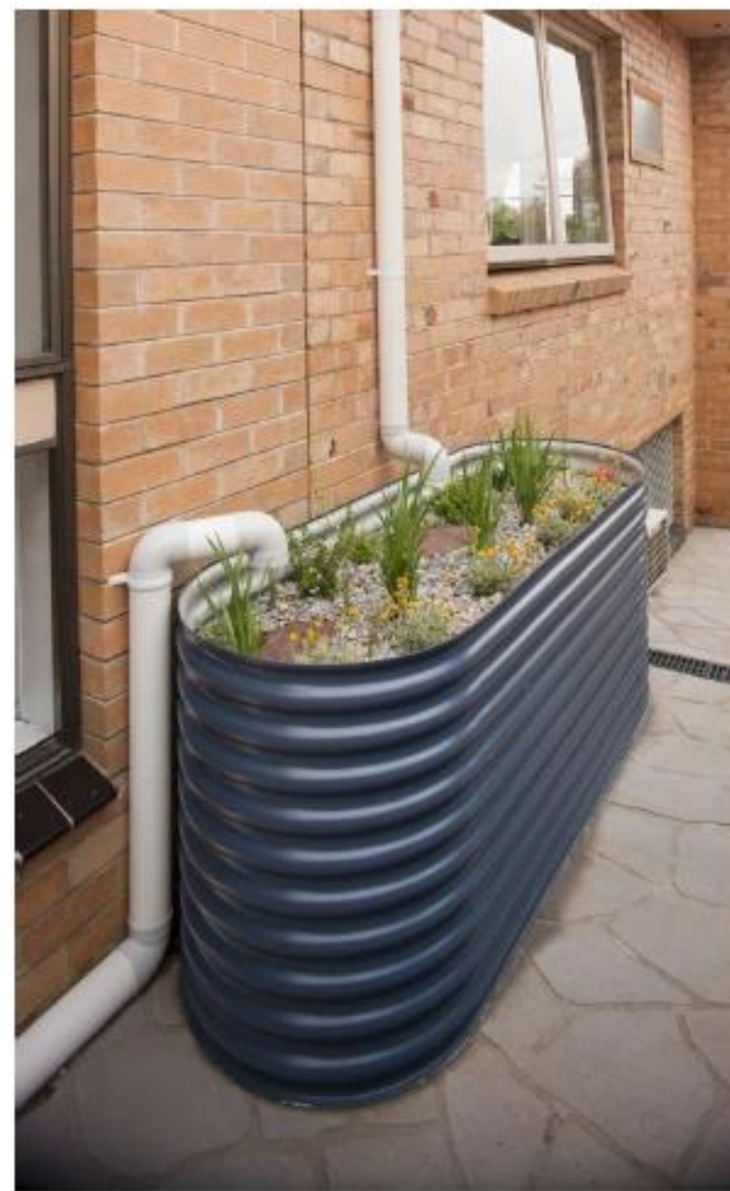
Rysunek 12. ClimaPond – bioretencyjny zbiornik zbierający wodę opadową z dachu przedszkola w Radomiu
