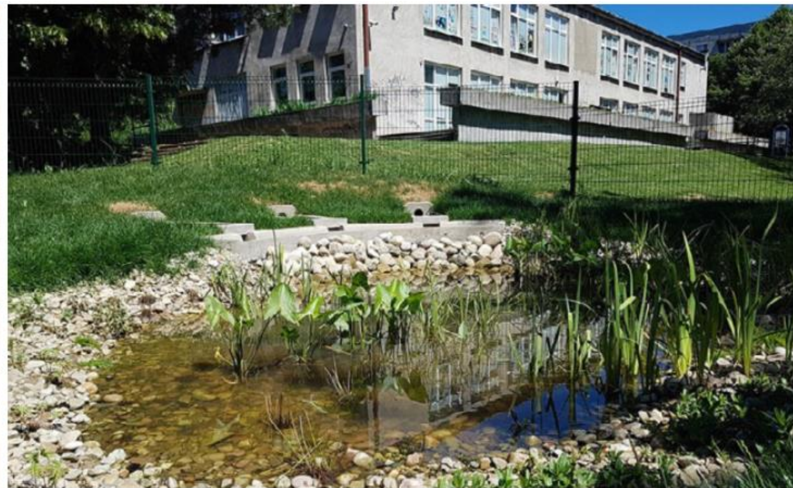
Rysunek 12. ClimaPond – bioretencyjny zbiornik zbierający wodę opadową z dachu przedszkola w Radomiu
